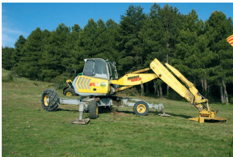
Retroaraña en posición de trabajo.
