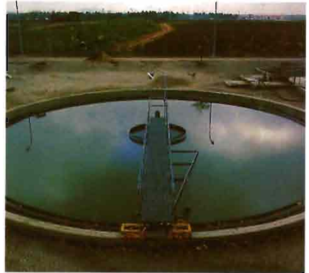
Estación depuradora de aguas residuales urbanas
