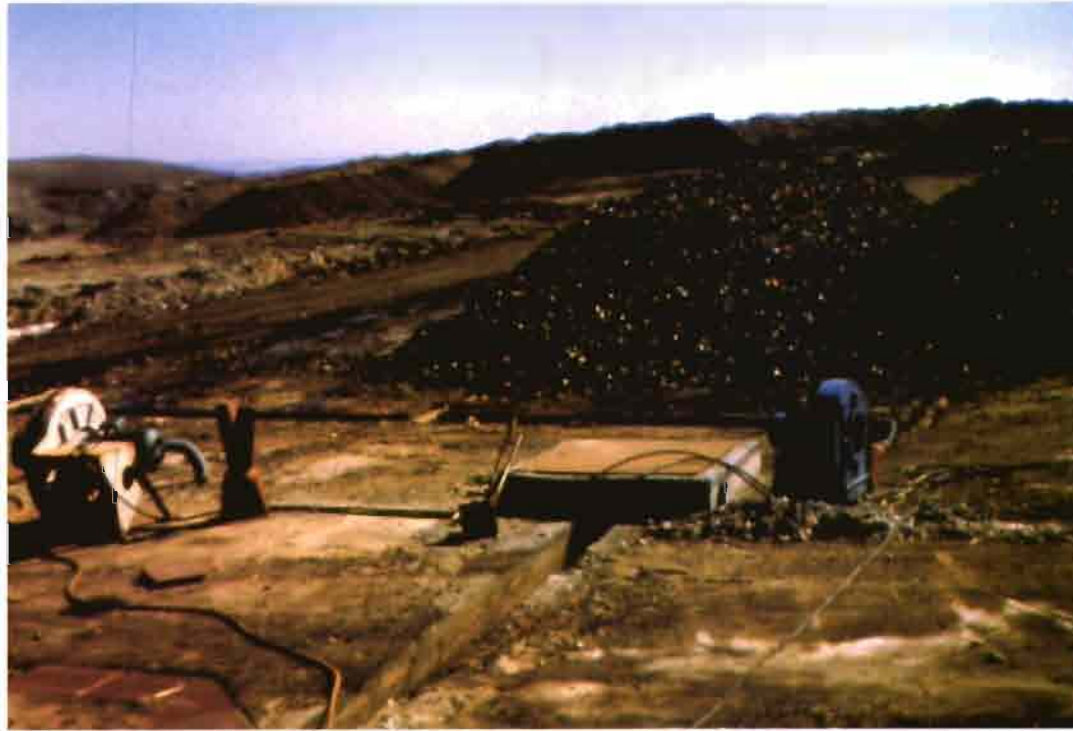
Parque para fermentar por vía aerobia los residuos biodegradables que se generan en una gran ciudad.
