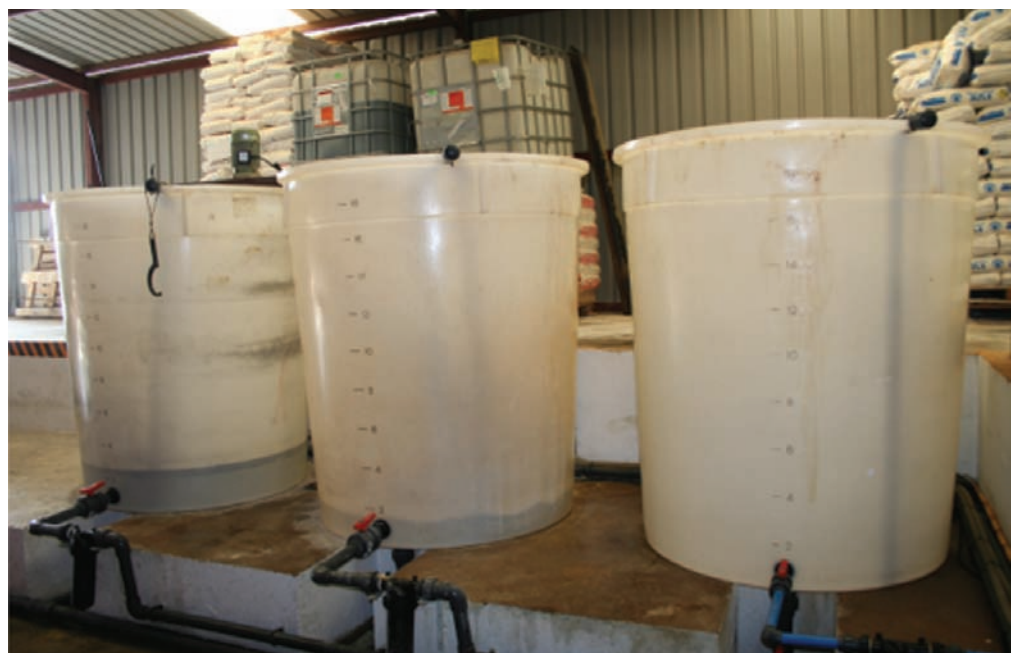
Aplicación del producto desde el cabezal de riego
