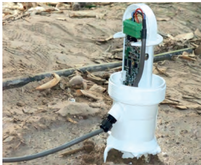
Cabeza de la sonda de humedad recién instalada con cable de conexión a datalogger
