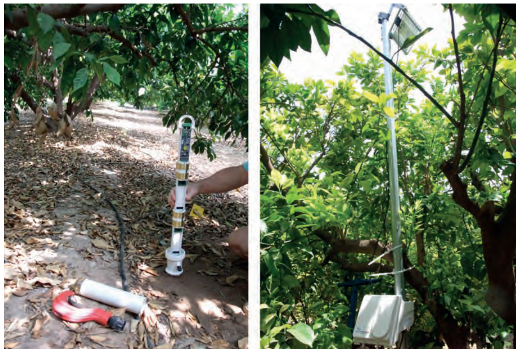
FOTO 1. Sondas. Detalle de la instalación y sensores. Sistema de almacenamiento y control
