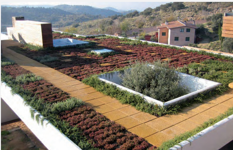
Vivienda unifamiliar, Urbanización Montesion (Toledo). Foto Intemper
