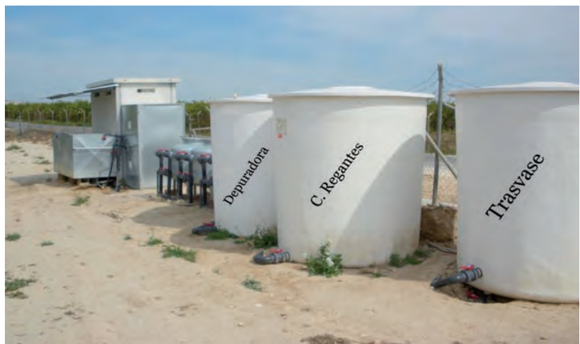
Foto 1. Cabezal de riego suministrado con tres fuentes de agua de distinta calidad.
