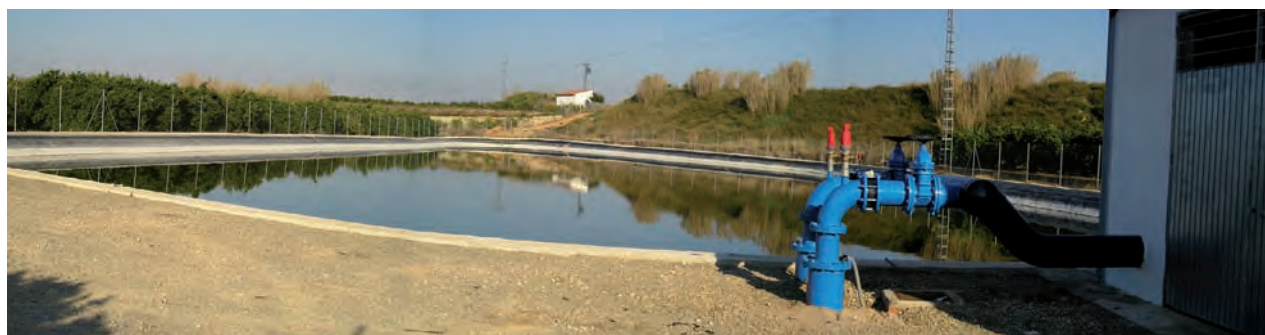
Balsa de riego terminada
