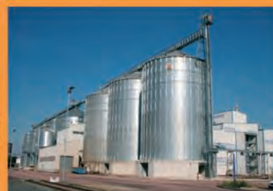
Planta de biodiesel
