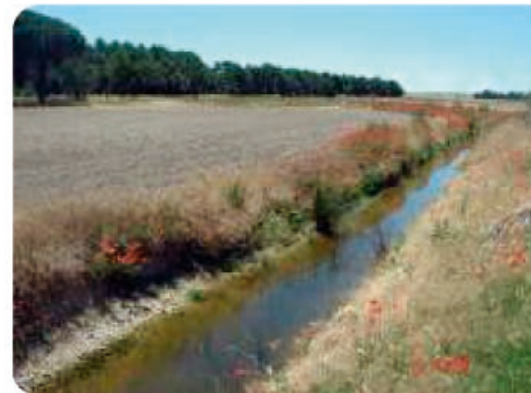
Figura 1: Perfil tipo de un dispositivo de recarga artificial (canal) en “control lateral” en una zona regable.
