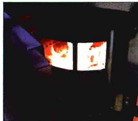
Detalle de la caldera encendida
