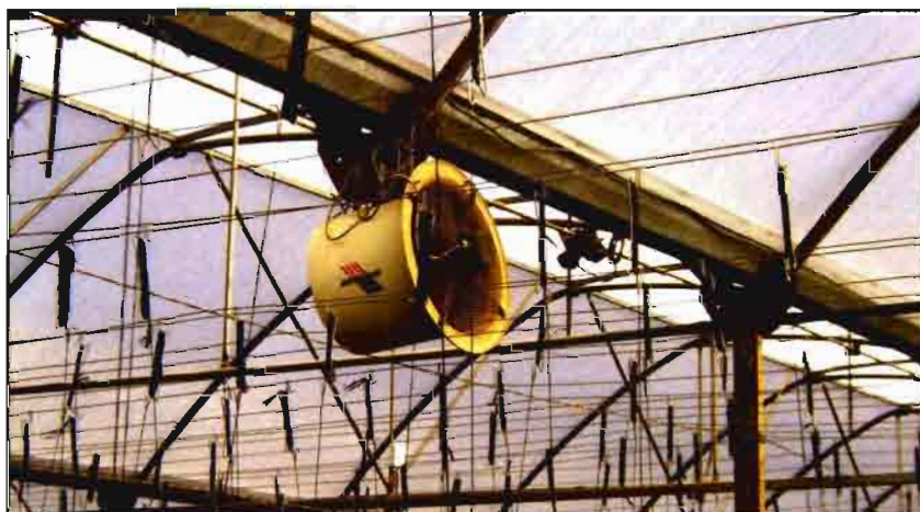
La ventilación forzada permite evacuar zonas de acumulación de calor como es el caso de las partes altas de invernaderos con pendiente
