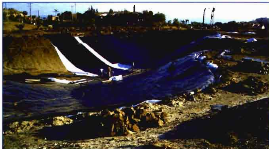
Construcción de lago artificial alimentado por agua depurada
