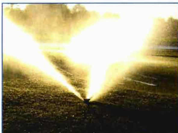
La regulación del gasto es primordial. Aspersor con exceso de presión
