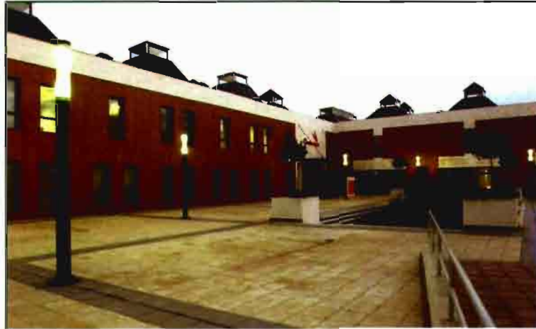
El moderno edificio de Centrorigen, ubicado en Mercazaragoza, acoge a la Dirección General de Fomento Agroalimentario del Gobierno de Aragón, los consejos reguladores, la Asociación de Industrias Agroalimentarias de Aragón y la Agencia Aragonesa de Seguridad Alimentaria, entre otros
