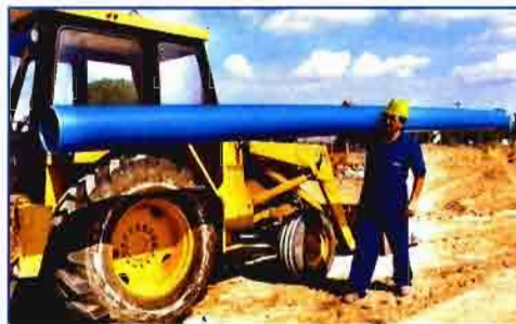
La ligereza de la tubería (DN 315 y 16 ATM) permite una rápida y cómoda manipulación en obra
