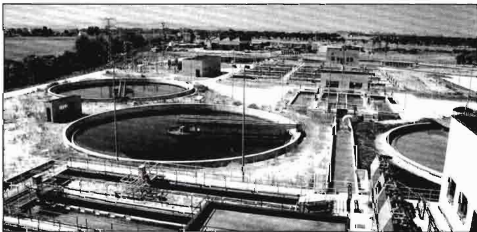
Decantadores de depuradora de agua.
