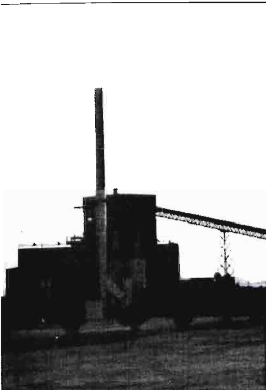
Central termoeléctrica de 12 MWatios alimentada con residuos de almazara ("alperujo") en El Tejar (Córdoba).
