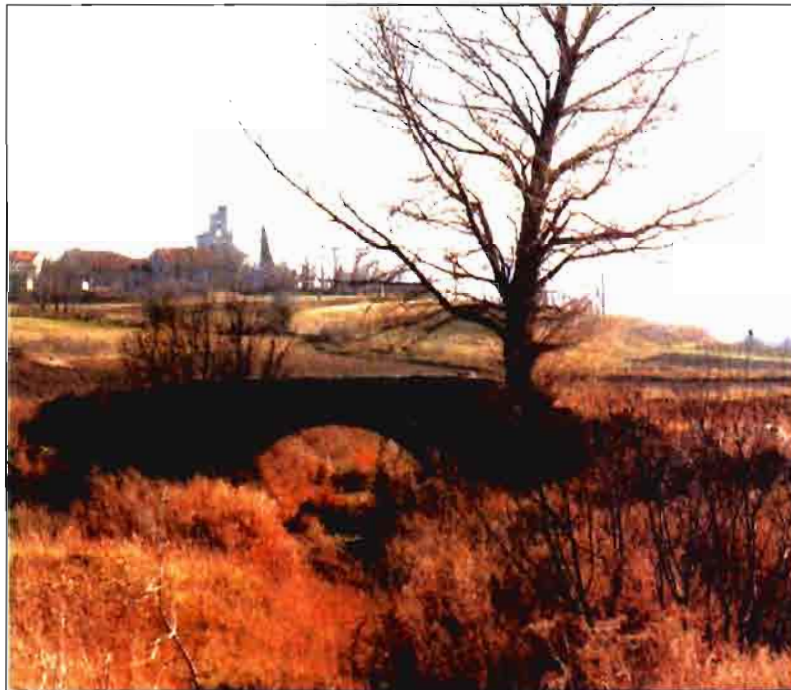
Agés. Puente de San Juan de Ortega. (Burgos).
