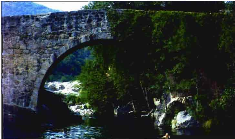
Puente de la Garganta de Cuartos (Losar de la Vera).
