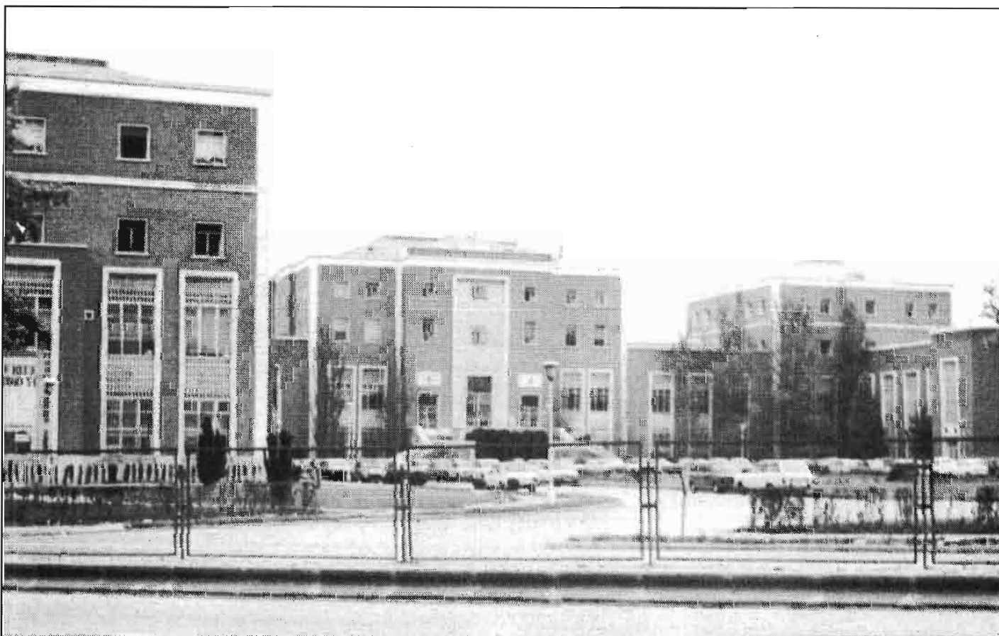
Fachada principal de la Escuela Técnica Superior de Ingenieros Agrónomos de Madrid, después de la última reforma externa.
