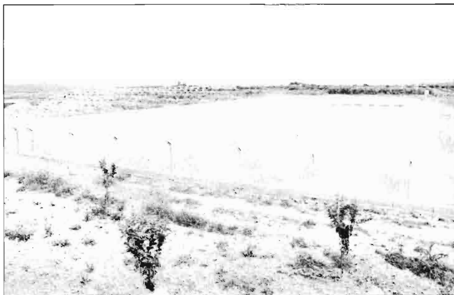
Sistema moderno de balsa reguladora para el riego.
