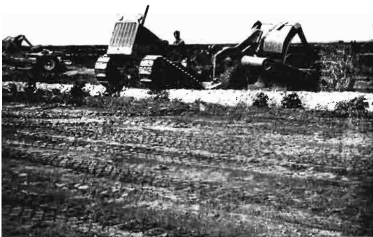
Nivelación de tierras en la zona regable del canal del Montijo.
