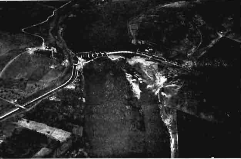
Presa de derivación de Montijo. En la margen derecha, el arranque del canal de Montijo. En la izquierda, el arranque del canal de Lobón.
