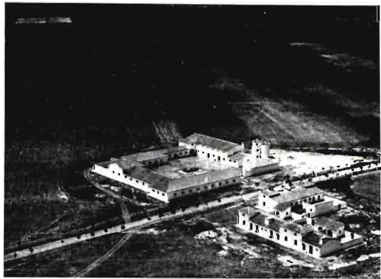
Cortijo de regadío de la finca «La Orden». Zona regable del canal de Lobón. Margen izquierda del Guadiana.
