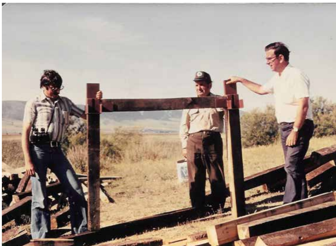
Iniciando la construcción de las pasarelas.
