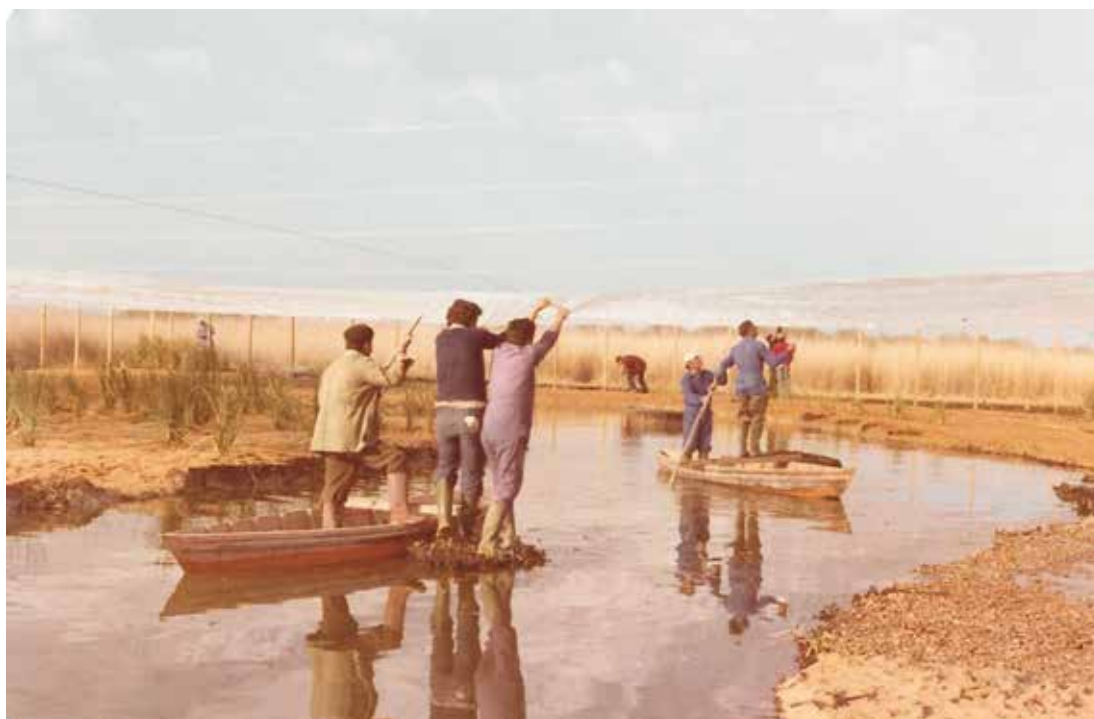
Construcción de la Laguna de Aclimatación.
