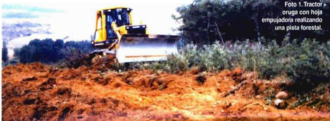
Foto 1. Tractor oruga con hoja empujadora realizando una pista forestal.
