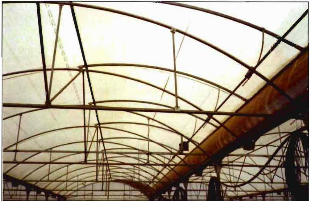
Fig.3: Ventana cenital de medio arco en un invernadero multitúnel.
