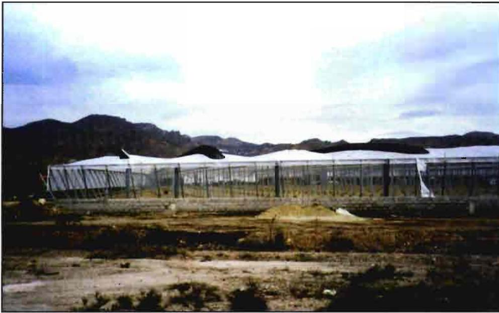
Fig.4: Invernadero tipo raspa y amagado con ventanas cenitales.
