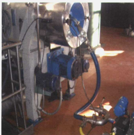
Foto 1. Sensores a la entrada del decanter. Foto 2 (abajo). Sensor de aceite.
