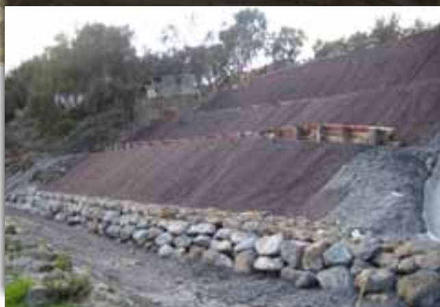
▲ Estabilización de taludes con técnicas blandas.
