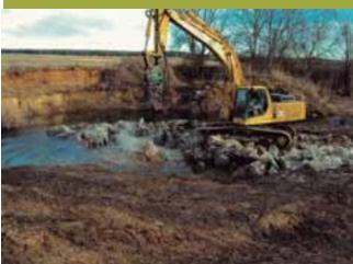
▲ La mejor medida que se puede adoptar para recuperar la conectividad longitudinal de un río consiste en la eliminación física del obstáculo, siempre y cuando éste ya no se use. Los dispositivos de paso deben entenderse siempre como una medida correctora provisional, que tiene sentido en tanto dure el aprovechamiento al que está ligada la infraestructura.
