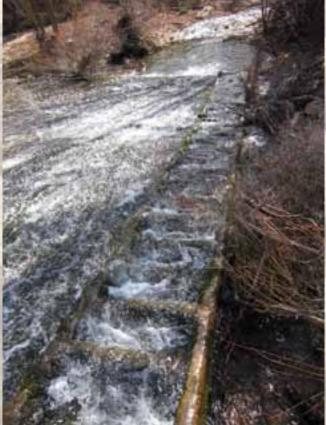
▲ Dos ejemplos de escalas con un diseño inadecuado, la de arriba por sus escasas dimensiones y su elevada pendiente, la de abajo, por el reducido tamaño de las artesas.
