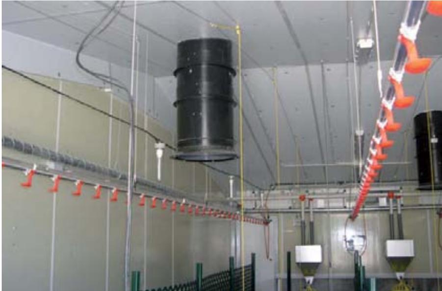
chadas principales del edificio y salidas de aire en la cubierta (caballetes y chimeneas). El aire frío procedente del exterior se calienta en el interior, se hace más ligero y sube hacia las aberturas de la cubierta por donde se elimina. El caudal de aire  $C_e$  que penetra en un edificio, debido a la acción del viento, se estima mediante la ecuación empírica:
