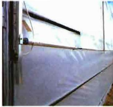
La apertura y cierre de ventanas, junto con la calefacción son instrumentos de control de humedad en el invernadero (foto Agrocomponentes).
