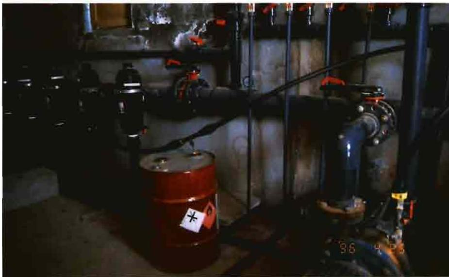
Una de las alternativas del bromuro de metilo. La inyección del DD a través de la red de riego para la desinfección del suelo. Foto: Cyanamid.
