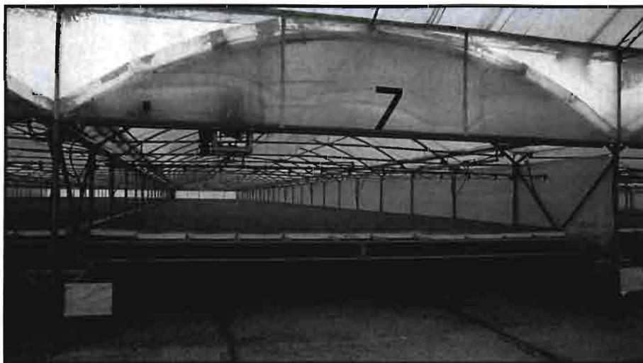
Estructura sobre la que se apoyan las bandejas, que puede ser desplazada por todos los invernaderos. Apoya lateralmente y se desliza sobre estos laterales.
