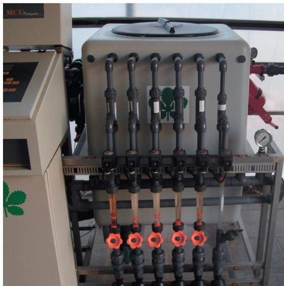
Figura 3. Detalle de un autómata de riego con las electroválvulas y los inyectores tipos venturi para la elaboración de la solución nutritiva.
