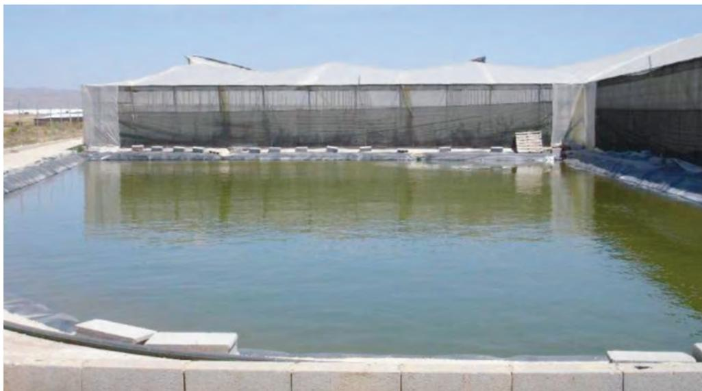
FOTO 2. Balsa construida mediante recinto de muros perimetrales
