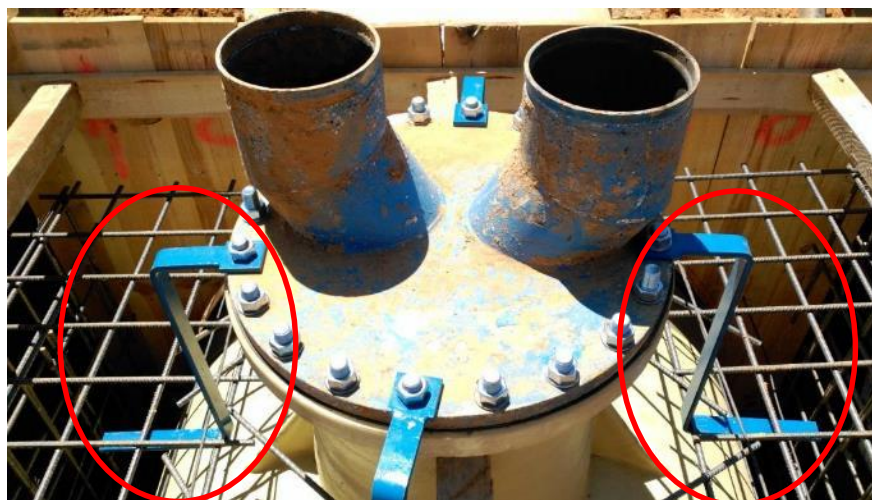
Rotura de la unión del cuello de la pieza
