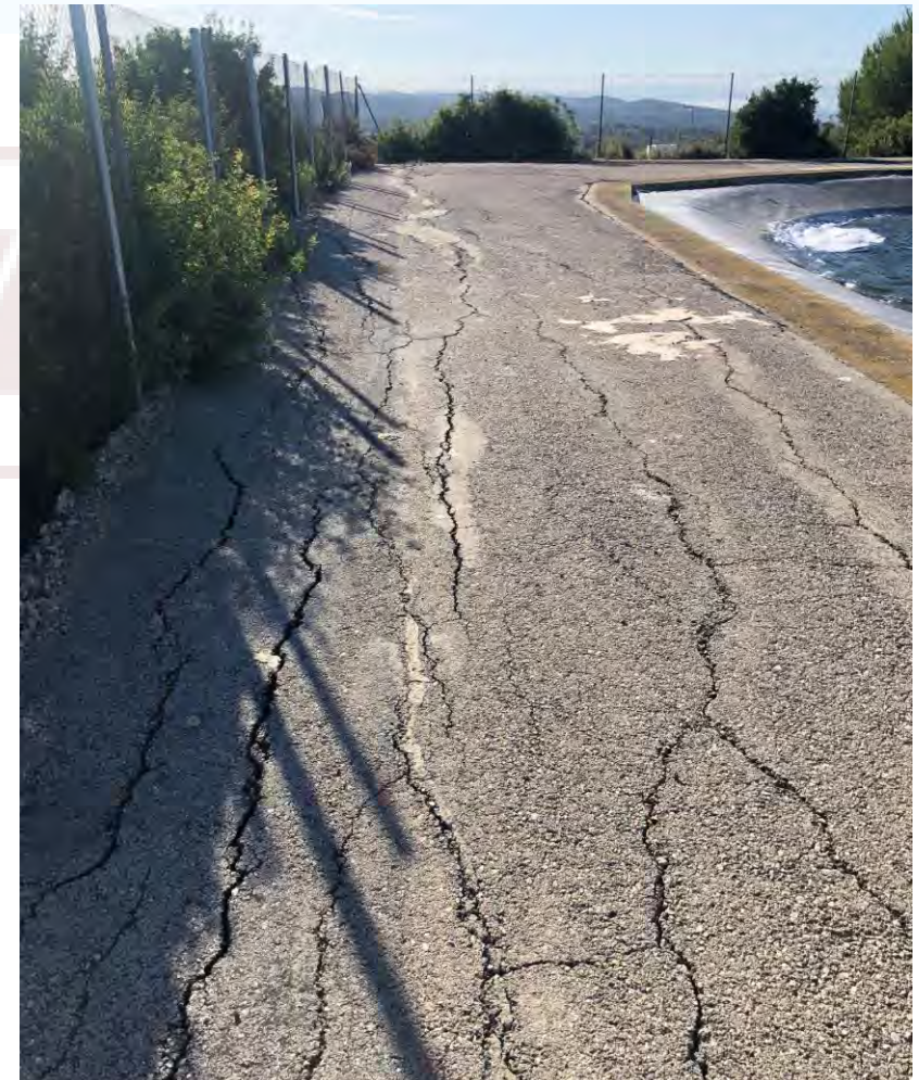
Vallado, mantenimiento caminos coronación
