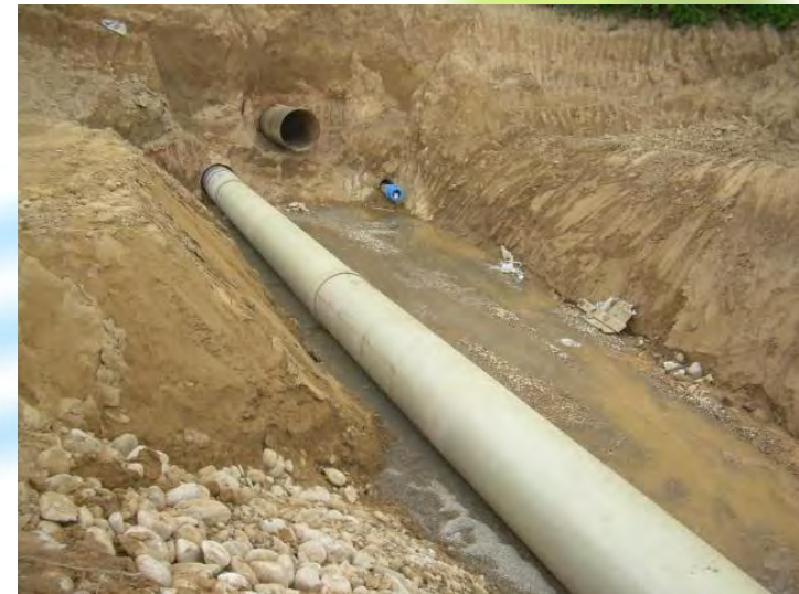
SALIDA TUBERÍA HINCADA
