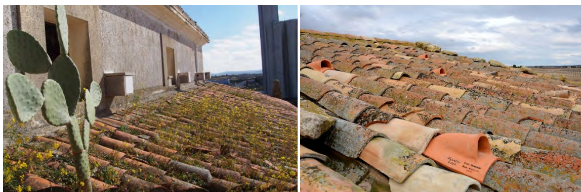
Imagen 85 - A la izquierda, colonia artificial de cernícalo primilla en fachada/tejado de edificio mediante cajas nido. A la derecha, colonia artificial de cernícalo primilla sobre tejado mediante tejas-nido.
