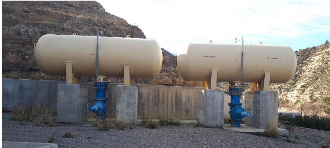
Calderines instalados en paralelo en la impulsión desde el Embalse de Mequinenza
