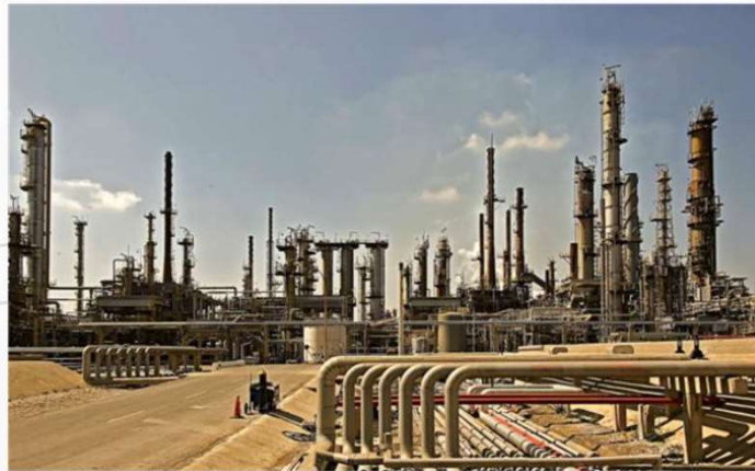
Refinería de BP en Castellón.. / LP
