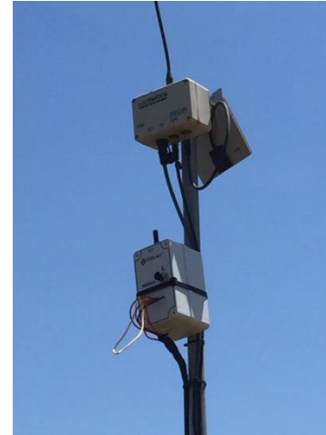
Sistema de adquisición de datos y telecontrol del riego
