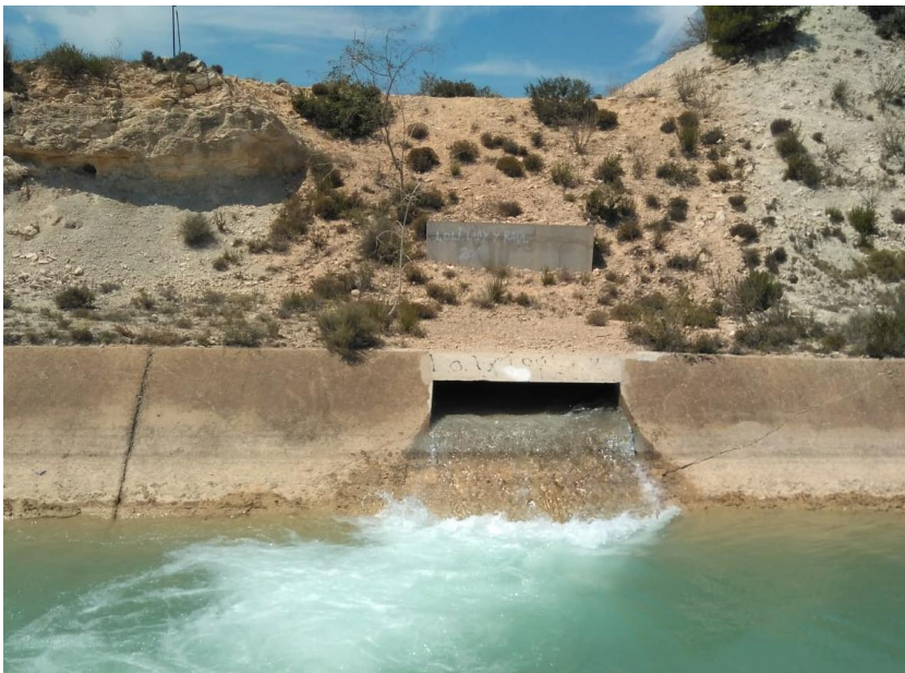
Punto de suministro agua procedente de la Desaladora de Torrevieja
