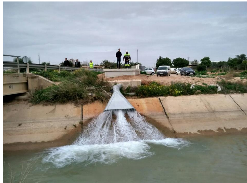
Punto de suministro agua procedente de la Desaladora de Escombreras
