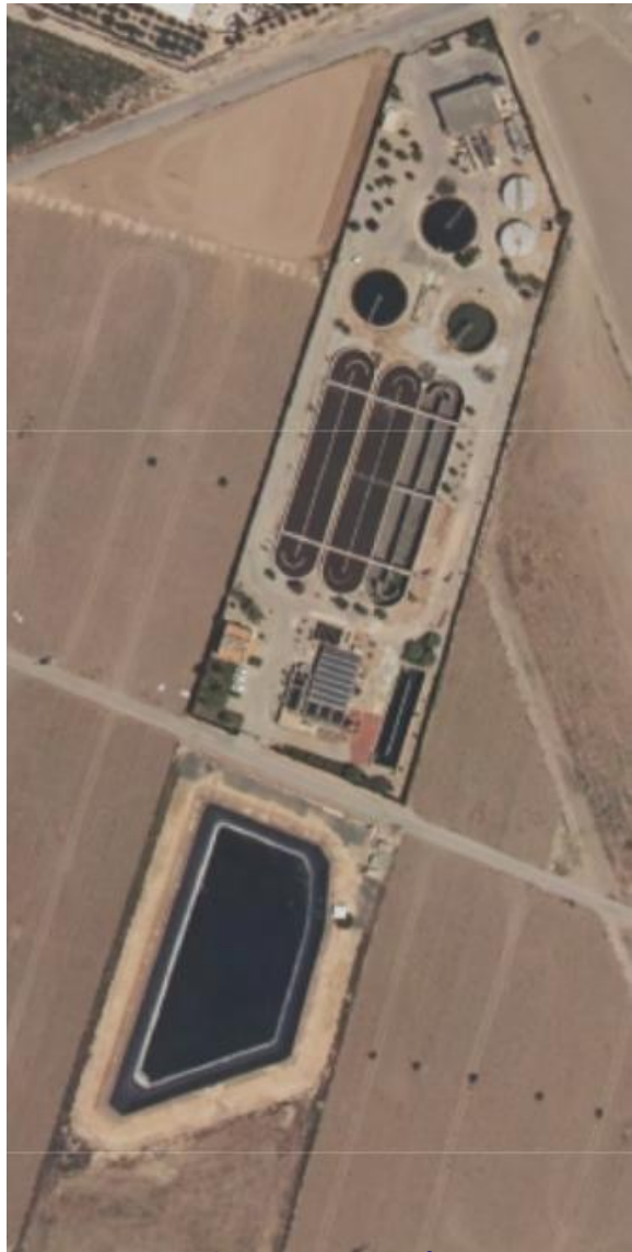
Punto de captación agua EDAR Torre Pacheco
