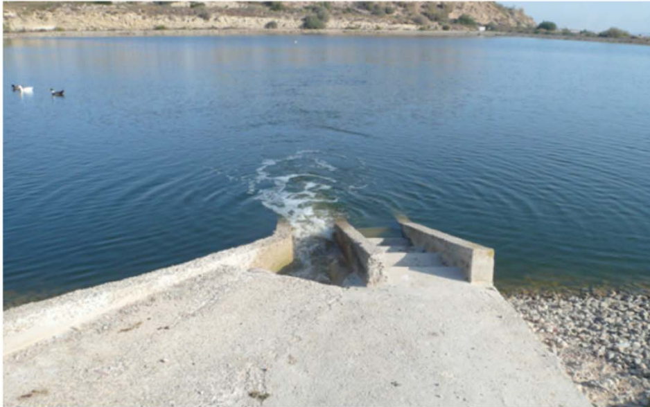
Fotografía N° 6.- Entrada de agua depurada a la balsa N° 1
