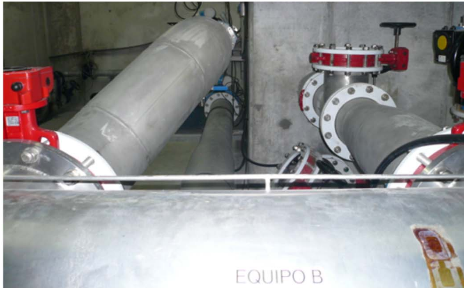
Fotografías N° 1 y 2.- Vista equipo tratamiento terciario Ultravioleta.
