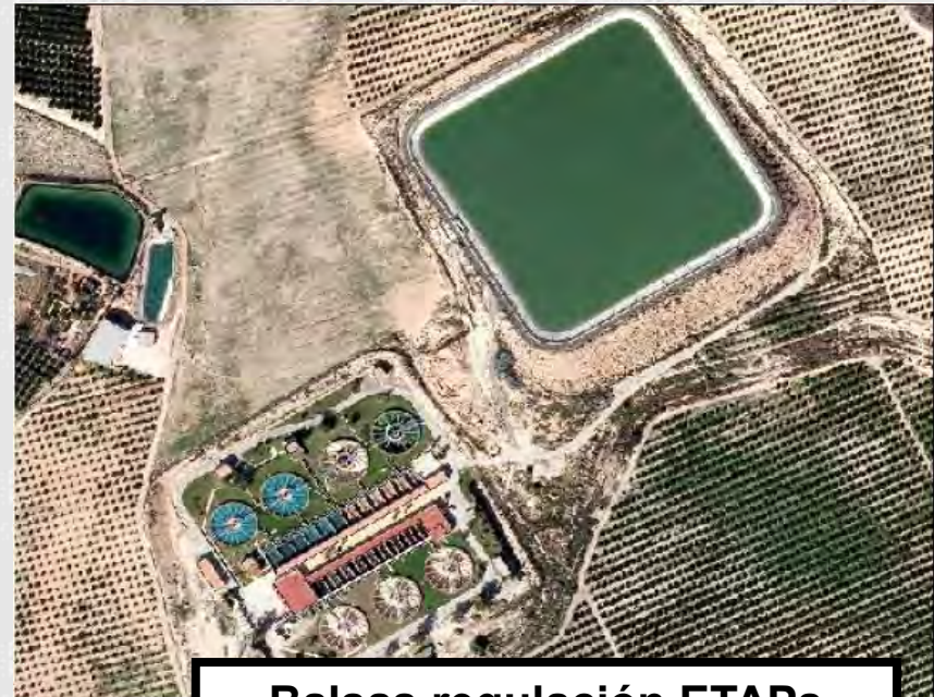
Balsas regulación ETAPs
