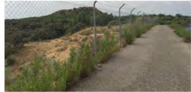
Estado vallado perimetral
