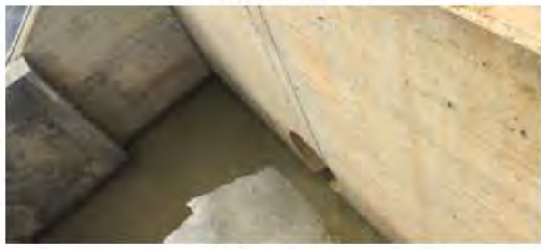
Inicio de la tubería de descarga del aliviadero
