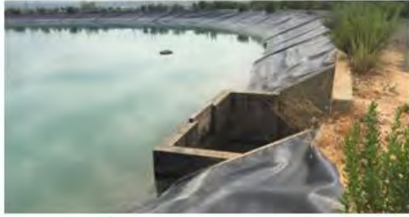
Estado del aliviadero
