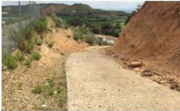
Estado de la rampe de acceso a la base
