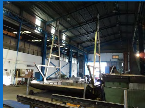
PREMONTAJE DE COMPUERTA
