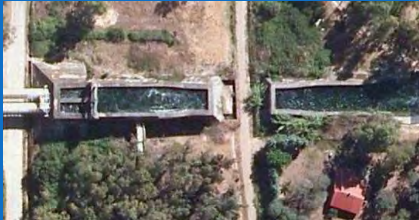
ARQUETAS DE AGUAS ARRIBA DEL SIFÓN
