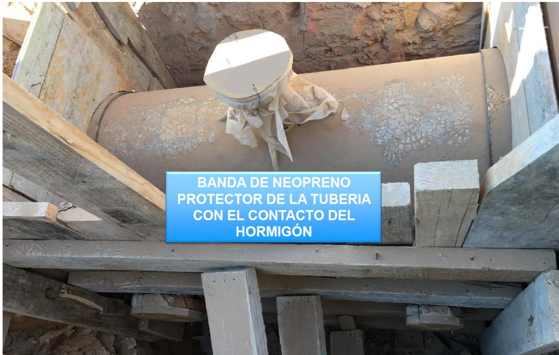
DETALLE DEL NEOPRENO Y TERMINADO
