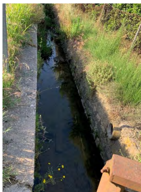
Figura 57. Localización del punto de control S02 de la red propuesta (Acequia Mas Roig, cruce CV-554 con riu Verd)
