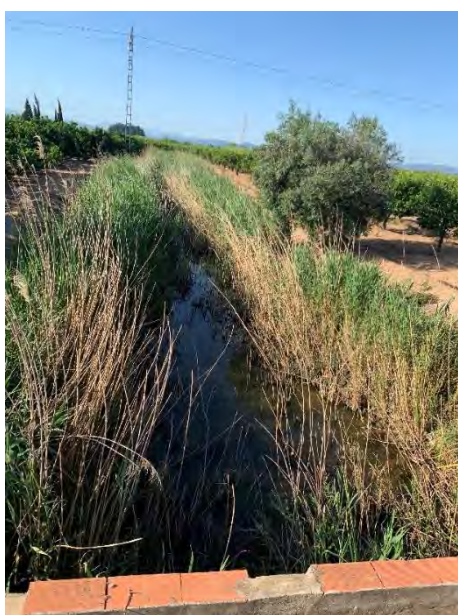
Figura 56. Localización del punto de control S01 de la red propuesta (Bco. Montortal)
