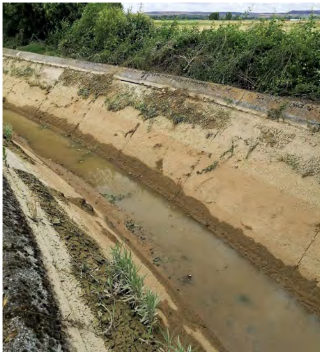
Imagen 5.- Situación actual del Canal de San José en Villalazán (Aprox. Km 37+300). Esta fotografía se ha realizado el 21/06/2021 en plena campaña de riego, durante una de las paradas que realizan de forma obligatoria semanalmente. Se puede observar la gran cantidad de depósitos de materiales en el fondo y paredes del canal, la presencia de vegetación en los taludes y la fisura continua en la unión entre el Canal y el recrecido del mismo que hubo que realizar para que el agua llegase al Sector I de la Zona regable (Zamora y Villaralbo). Las marcas de nivel en los taludes, indican que el agua en el Canal está normalmente por encima de dicha fisura sin prácticamente ningún resguardo.
