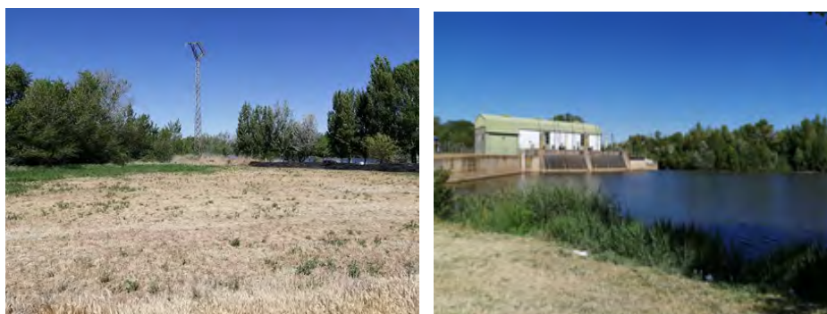
Imagen 67 y 68: Ubicación prevista de la estación de bombeo y obra de toma.
