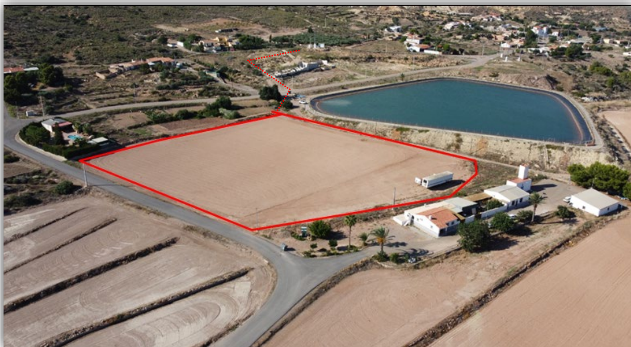
Figura 4. Fotografía actual de la zona de actuación. Se pueden observar las parcelas donde se ubicarán las instalaciones perimetradas en rojo.
