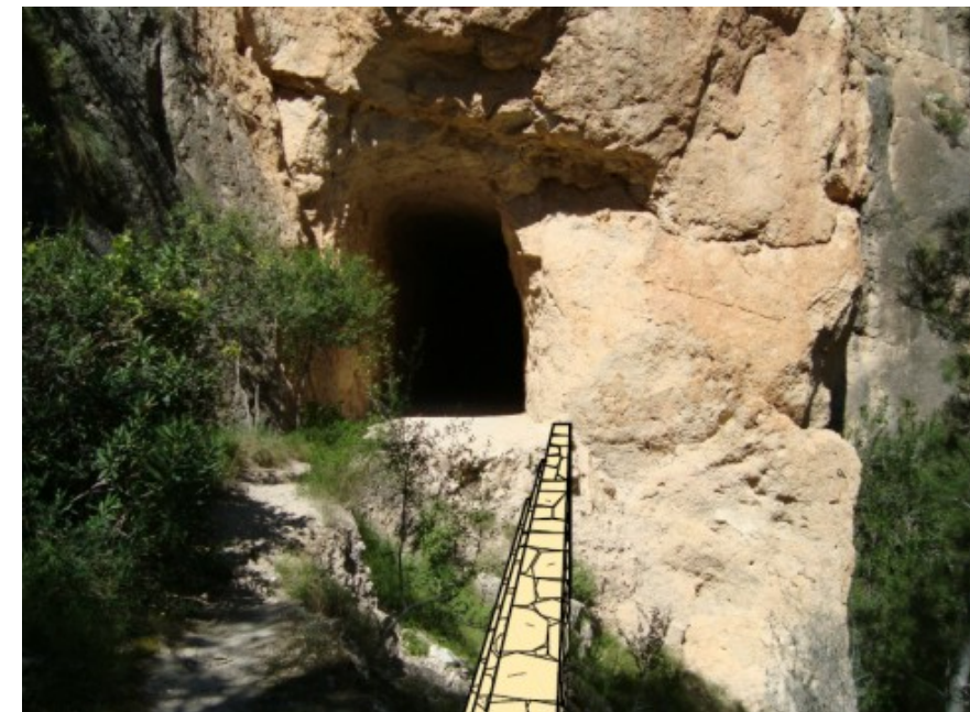
Obras de mampostería para recuperación de camino deteriorado
